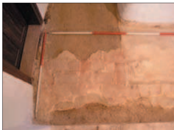
Starija hodna površina – podloga za popločenje izrađena u vapnenoj mortu s otiscima opeke (foto: J. Živković)
